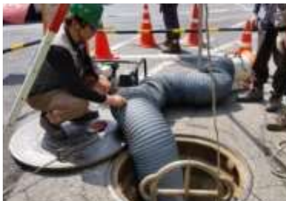
[그림 2-8] 산소 및 유해가스 농도 측정기 및 환기장치
